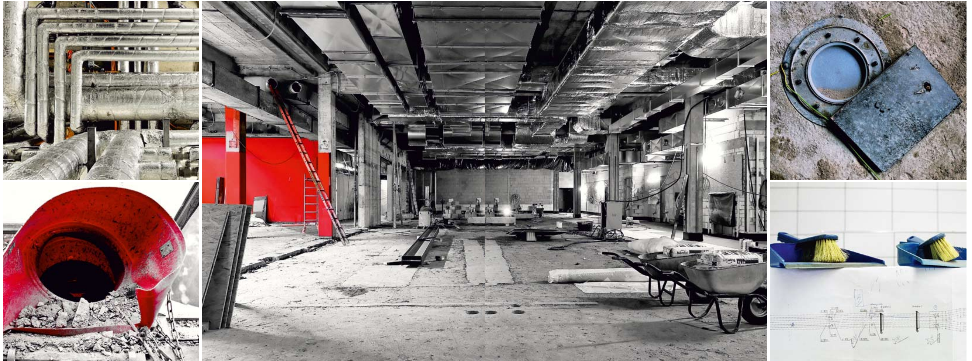
Im größten Chaos kommt Humor ins Spiel: Die Bauschuttrutsche wird zum »sound of silence« und für die Baustelle heißt es »waiting for a miracle«.
