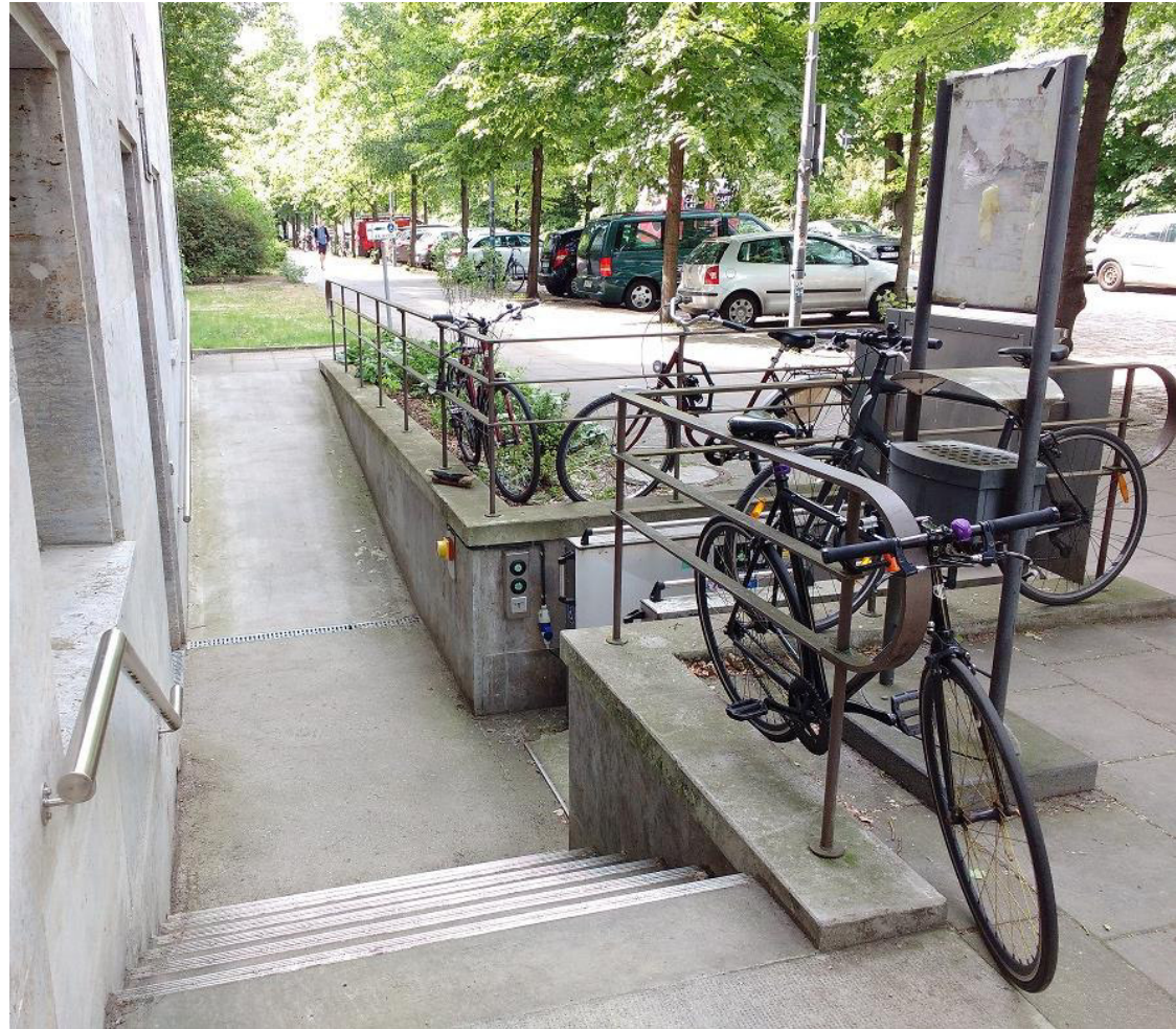
Zugang zum E-R Gebäude mit zusätzlichem Hebelift und Handlauf für die Treppe und Rampe
