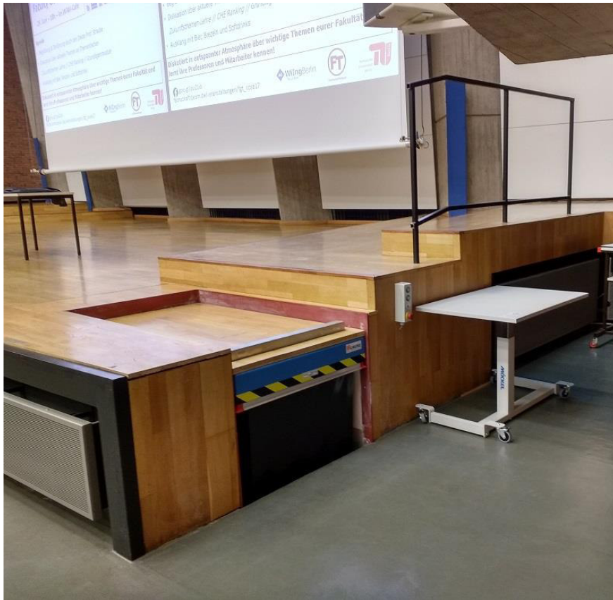
In die Bühne eingelassener bodengleicher Hebelift im Audimax der TU Berlin
