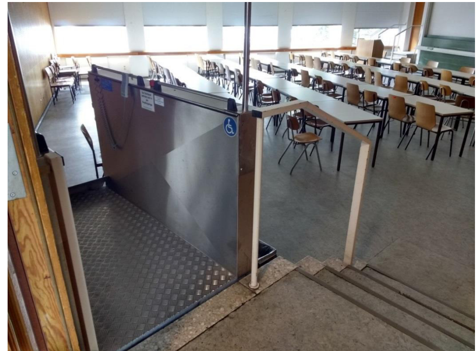
Hebelift im Seminarraum A60 des Architekturgebäudes
