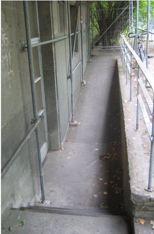
Zugang zum E-R Gebäude über schmale und steile Rampe
